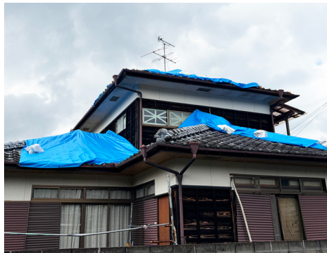
屋根をブルーシートで応急処置した住宅
