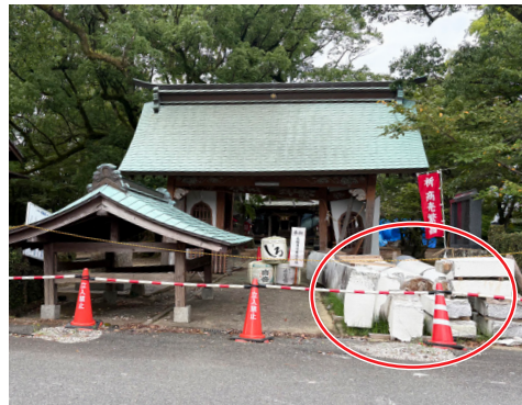
大鳥居が倒壊した宮原三神宮 (写真右下は倒壊した鳥居)
